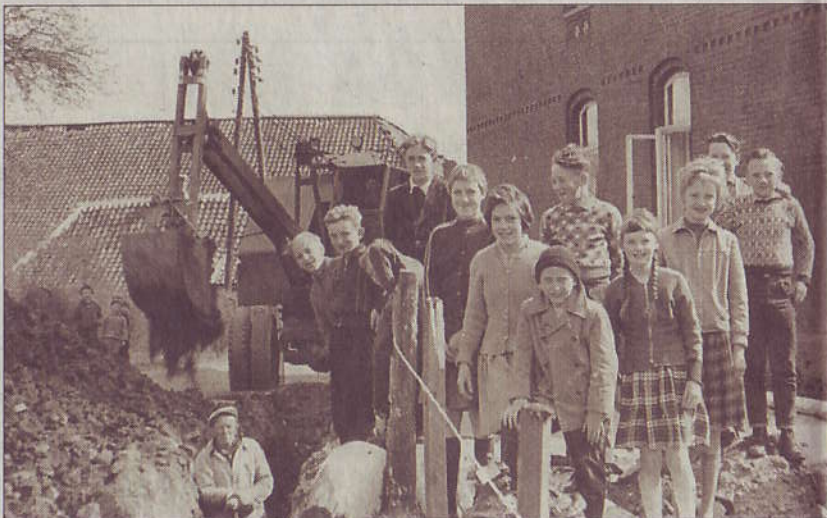
Im Frühjahr 1960 erhielt das Krummhörner Dorf Groothusen eine Wasserleitung. Der Lehrer Julius Geweke fotografierte, wie ein Bagger bei der Schule den notwendigen Rohrgraben aushob.
